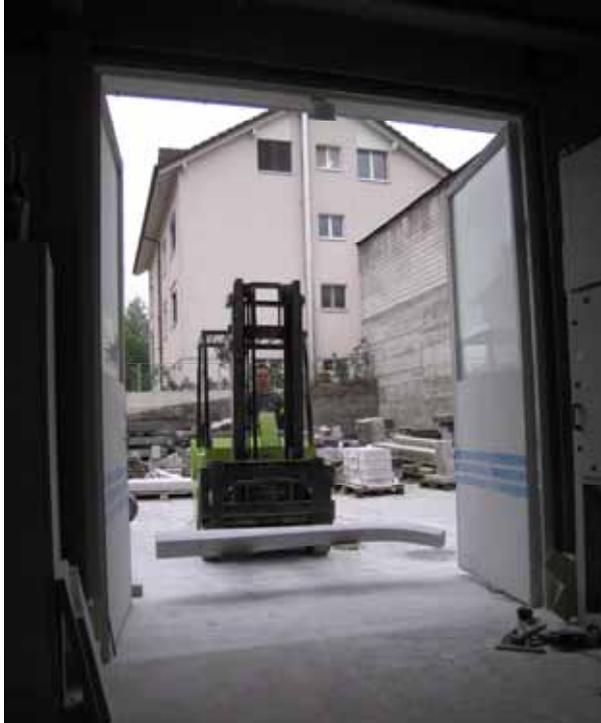
Die einzelnen Elemente müssen mit allergrösster Sorgfalt behandelt werden. Lang und dünn wie sie sind, würden sie bereits bei einem Sturz aus geringer Höhe brechen. Gerade noch knapp lassen sie sich mit dem Stapler durch das grosse Tor fahren.
